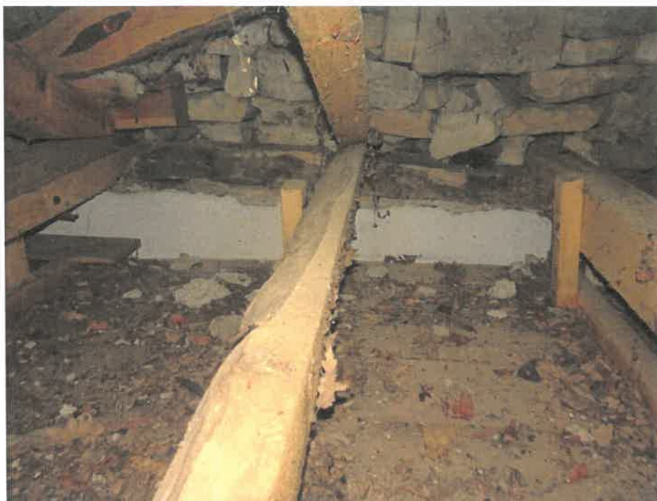
Νότια Πτέρυγα – Εσωτερικό στέγης σε κακή διατηρούμενη κατάσταση – Μείωση διατομών ελκυστήρων ζευκτών
