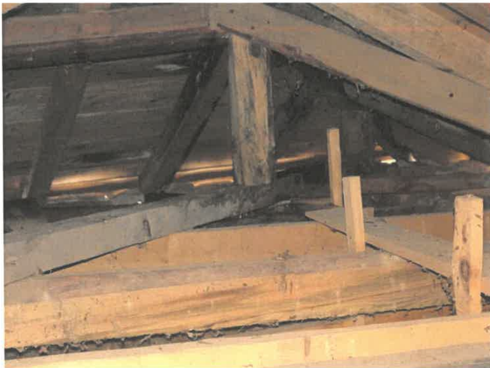
Νότια Πτέρυγα – Εσωτερικό στέγης με εσφαλμένη διάταξη δομικών μελών και σε κακή διατηρούμενη κατάσταση
