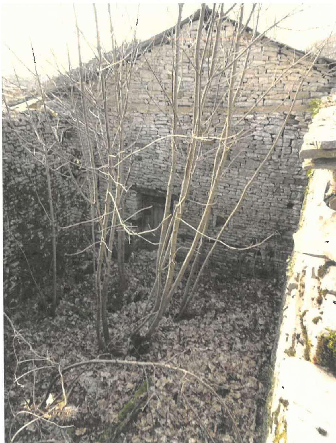
Νότια Πτέρυγα – Νότια περιοχή – Απουσία στέγης στον υπό διαμόρφωση κοτώνα Β3 του Α' Ορόφου
