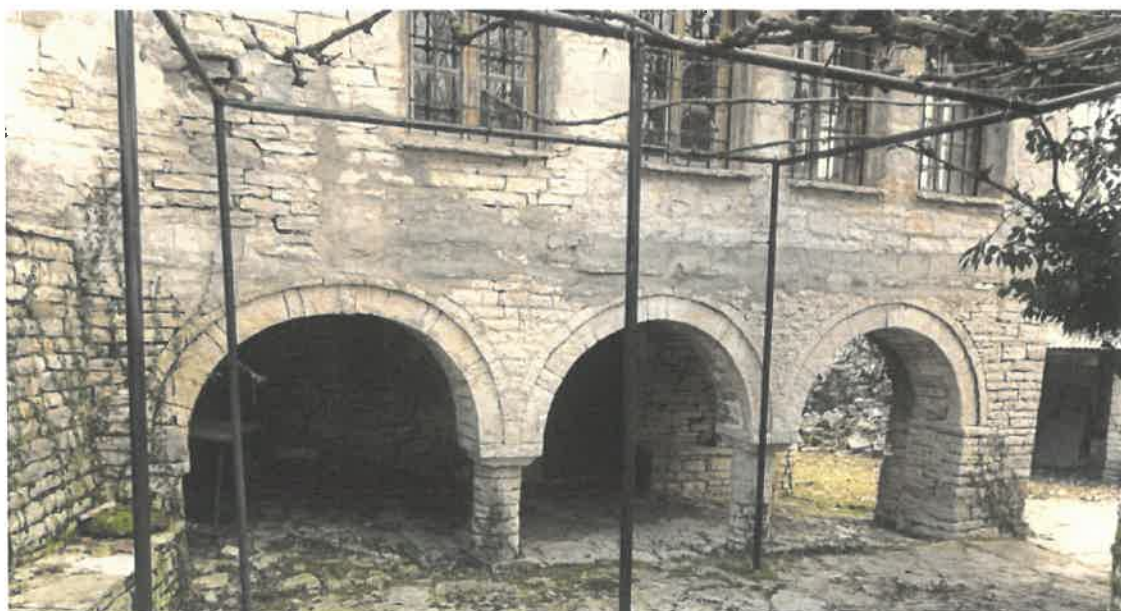
Νότια Πτέρυγα – Βόρεια Οψη – Διακρίνονται πρόχειρες επισκευές με αρμολογήματα στην πρόσοψη, που έλαβαν χώρα κατά το παρελθόν
