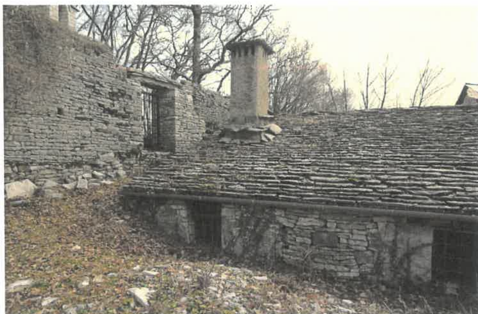
Νότια Πτέρυγα – Βόρεια Οψη – σφράγιση παλαιότερων ανοιγμάτων με ακανόνιστης διάταξης λίθους
