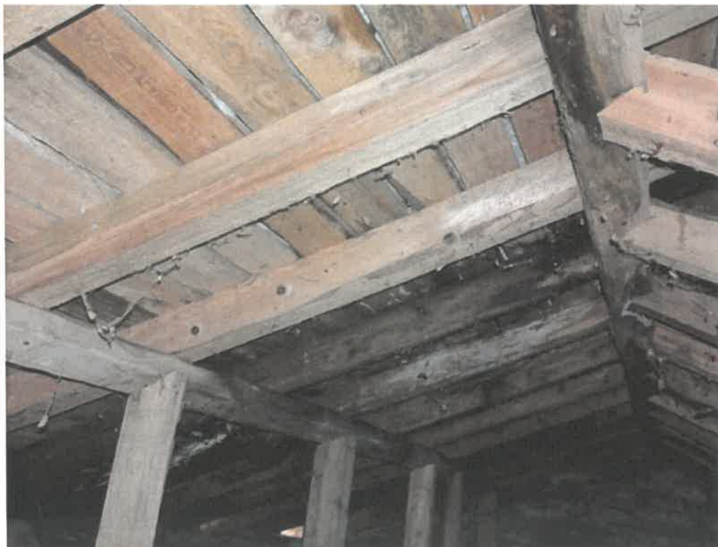
Νότια Πτέρυγα – Εσωτερικό στέγης σε κακή διατηρούμενη κατάσταση – Σήψη ξυλείας
