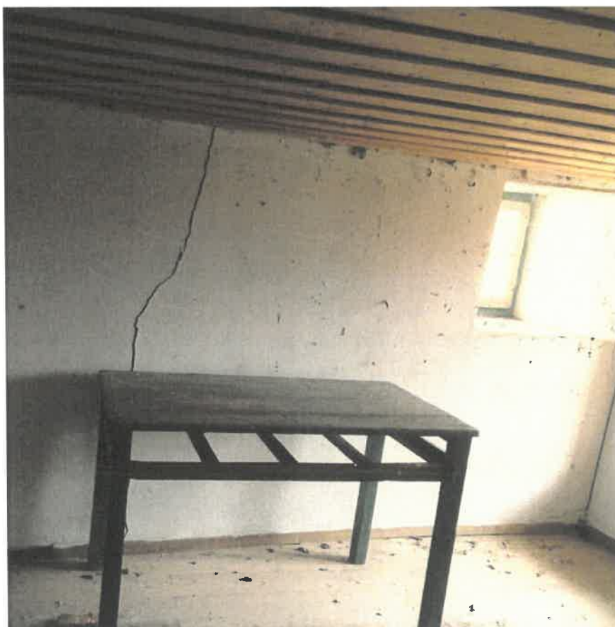
Νότια Πτέρυγα – Μικρού εύρους ρηγμάτωση στο εσωτερικό της Τοιχοποιίας
