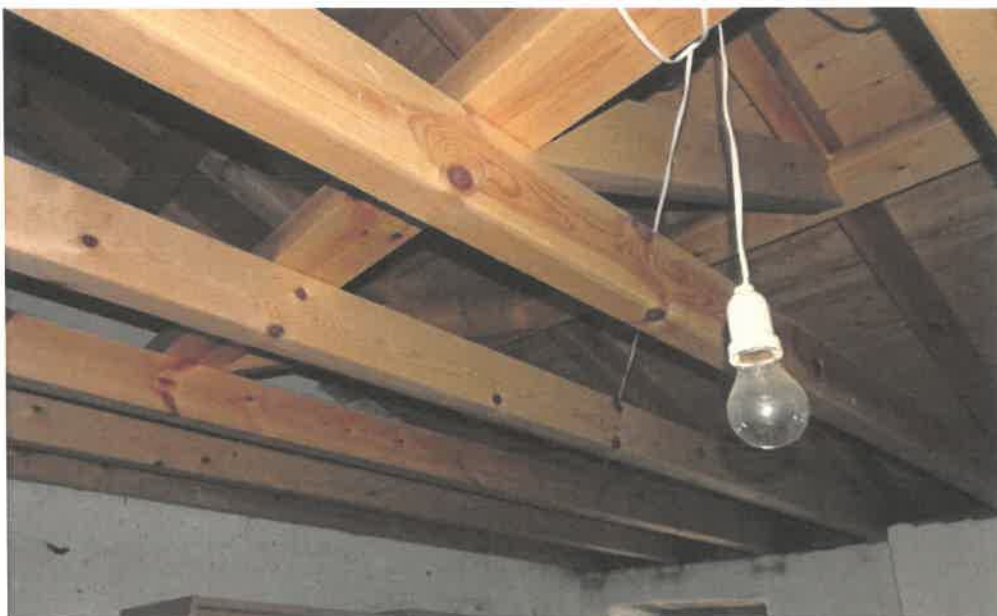
Νότια Πτέρυγα – Ανακατασκευασμένο τμήμα στέγης στην Βόρεια πλευρά, διατηρούμενο σε πολύ καλή κατάσταση
