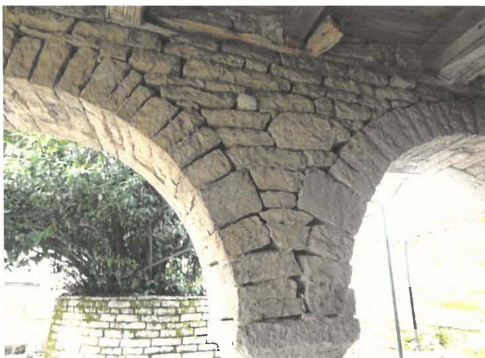
Νότια Πτέρυγα – Βορεινή περιοχή – Ελλειψη συνδετικού κονιάματος μεταξύ των λίθων
