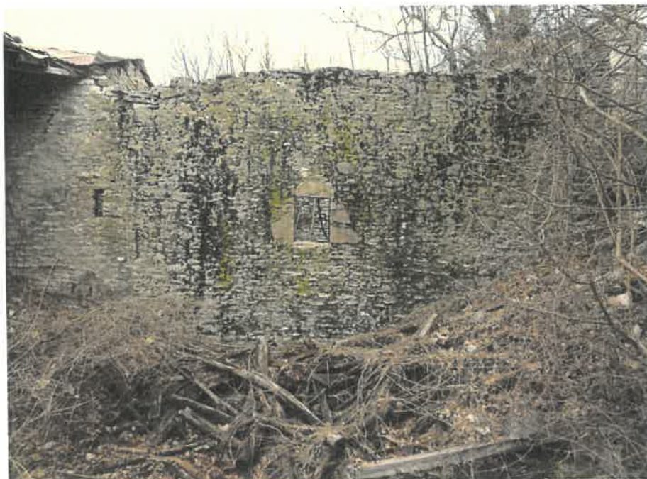
Νότια Πτέρυγα – Νότιος Τοίχος που θα καθαιρεθεί και θα επανακτισθεί, διότι φέρει κύρτωση και απόκλιση από την καθετότητα
